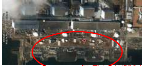
海に面した多くの構造物が破壊されている
